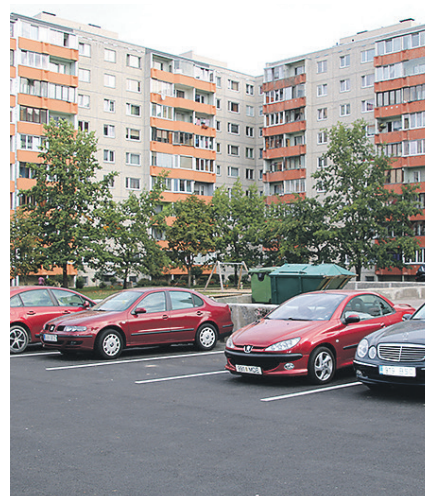
Недавно открывшаяся парковка по адресу ул. Линнамяэ тез, 81.
