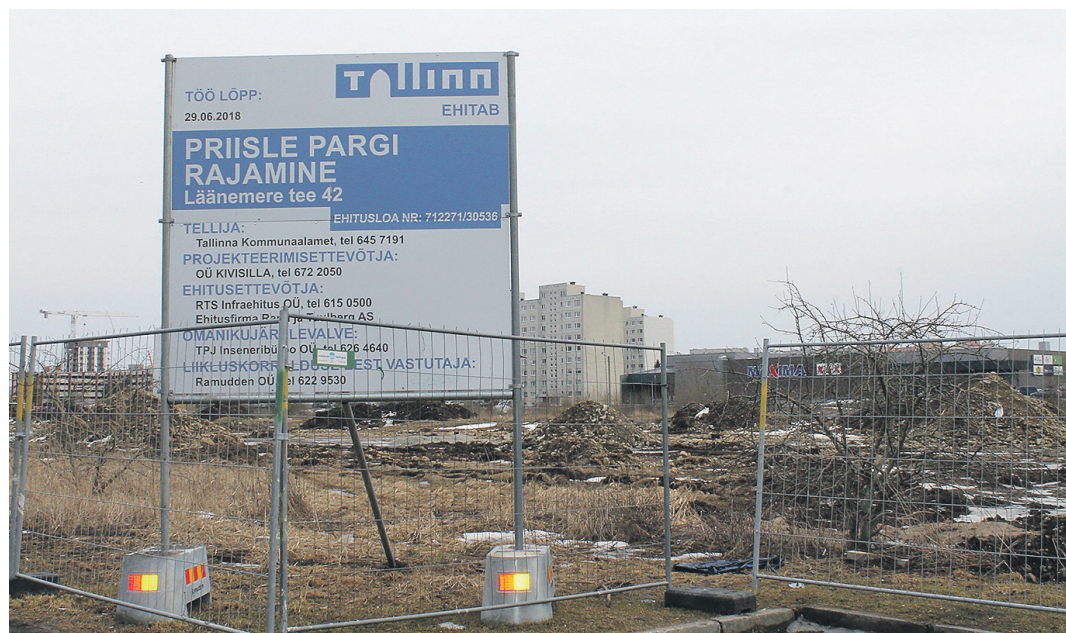
Строящийся парк Прийсле
