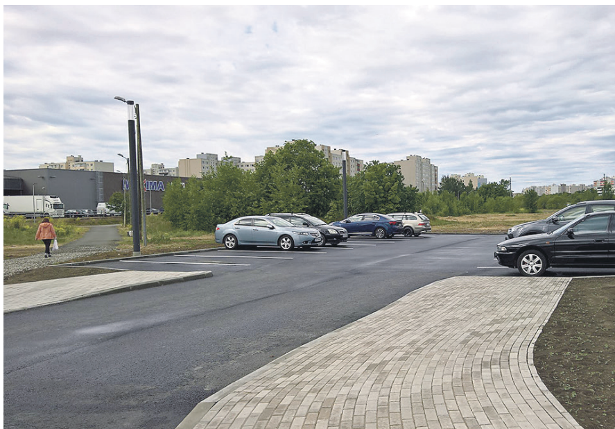
Priisle pargi ehituse II etapi käigus rajati kolm projektikohast parklat
